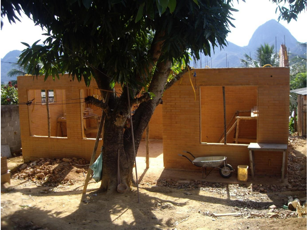
Construction de maison à Cariacica à partir des briques écologiques fabriquées par la coopérative d'Ateliê de Ideias
